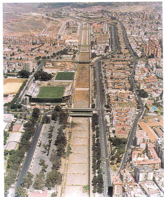
Estado actual del cauce
