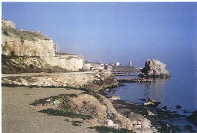
Zona del Peñón del Cuervo en donde ha de desembocar el túnel-aliviadero del embalse del Limonero
