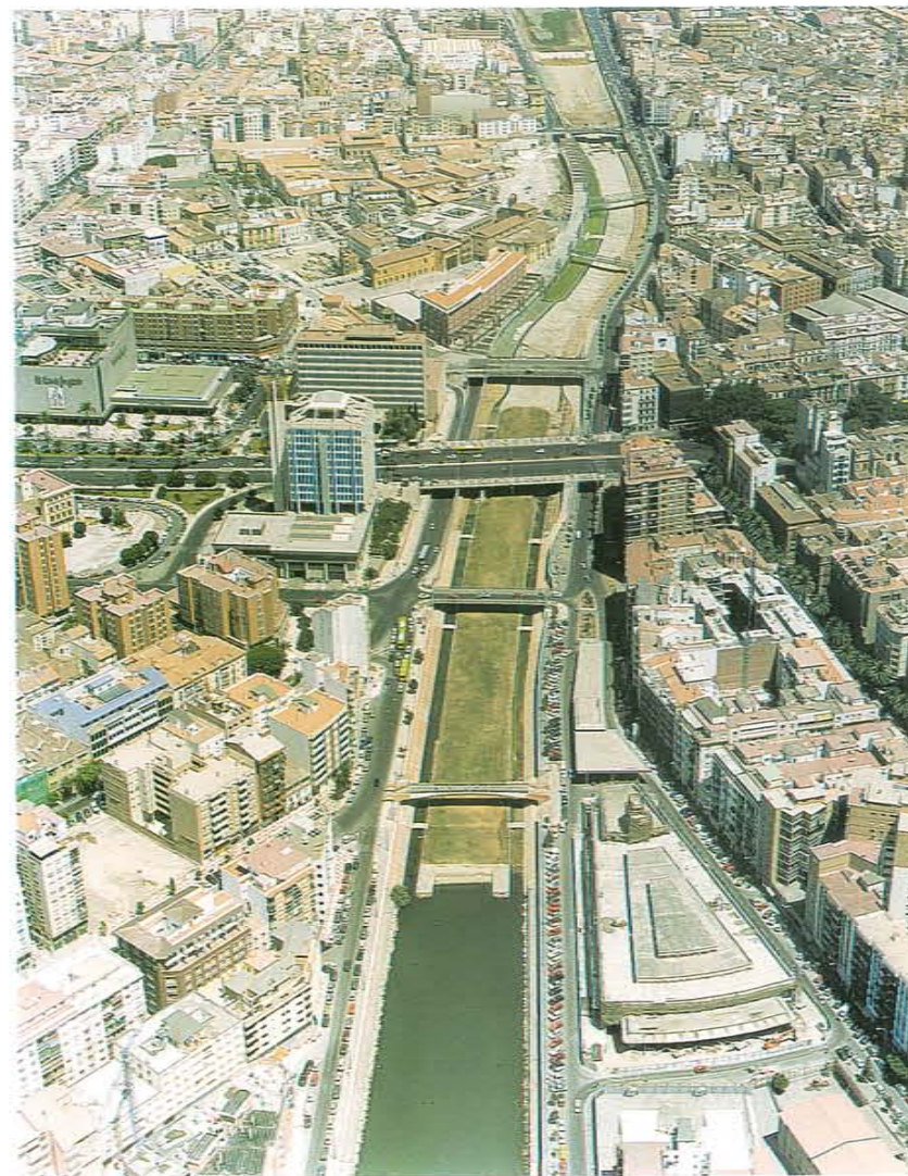
Estado actual del cauce
